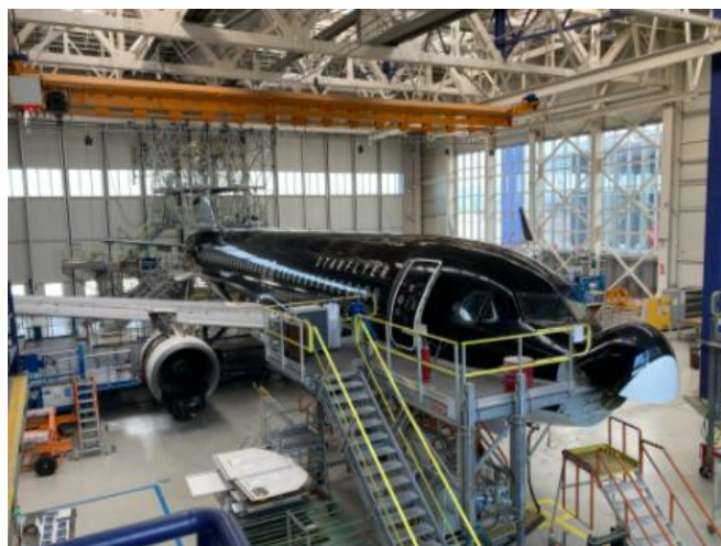
[委託整備での作業の様子]
